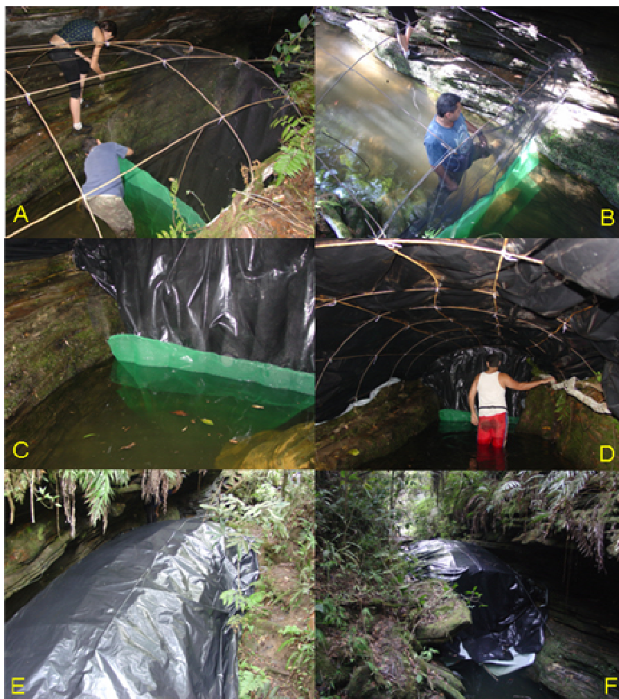
FIGURA 6 (A) Arcabouço da estrutura com os vergalhões unidos por arame e fixados à rocha; (B) instalação da rede de contenção para a barragem de entrada de matéria orgânica; (C) detalhe da rede de contenção sobreposta pela lona; (D) vista do interior da estrutura na posição jusante para montante, com dimensões de altura e largura; (E) vista superior, demonstrando a extensão da estrutura na posição jusante para montante e (F) vista parcial da estrutura na posição montante para jusante.
