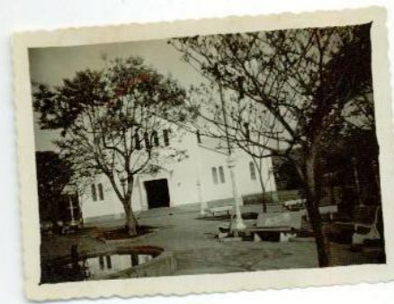
Poço de água ao centro do jardim
