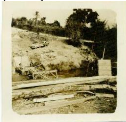
Trabalhos de construção da ponte sobre o Rio Ingaí em outubro de 1963
