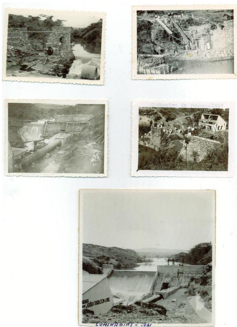
Fotos da construção da barragem e a mesma depois de pronta
