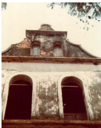
Torre da Igreja Velha antes da primeira reforma
