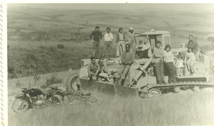
Imagens da construção da Estrada Luminárias – Lavras Via Poço Bonito
