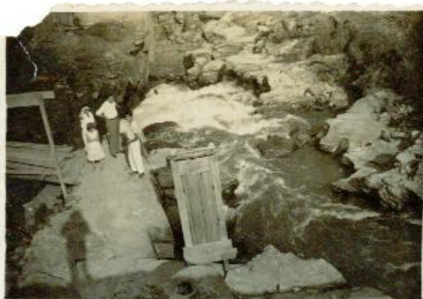
Banheiro improvisado para uso dos trabalhadores da Usina. Feito de madeira e colocado na superfície do rio.
